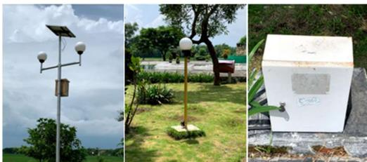
**Gambar 8.** Lampu dengan sistem *solar panel* dan lampu dengan sistem listrik langsung (sumber: dokumentasi penulis, 2021)
