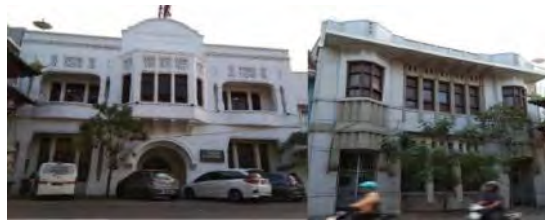
Gambar 7 dan 8. Bangunan Kolonial (sumber: penulis, 2020)
