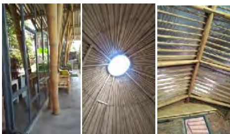
Gambar 11. Material Bambu sebagai Struktur Atap (sumber: Dokumen Pribadi, 2019)
