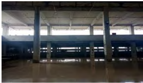
Gambar 14. 3 rd Floor HTC (sumber: dokumentasi peneliti, 2019)
