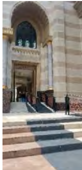
Gambar 3. Arsitektur Masjid Al-Aqsha Klaten
