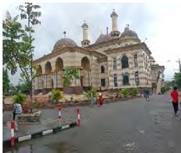
Gambar 4. Arsitektur Masjid Al-Aqsha Klaten
