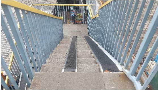
Gambar 10. Ramp pada tangga akses (Sumber: Dokumen Penulis, 2023)
