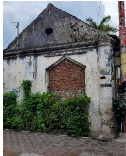
Gambar 8. Atap Pelana pada Bangunan Sampel (sumber : Dokumen Penulis, 2024)
