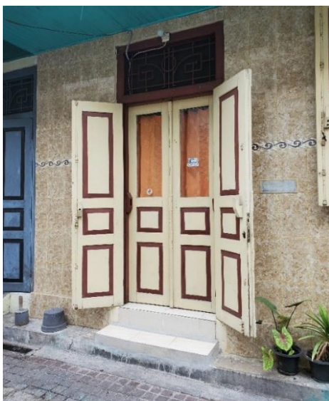
Gambar 7. Finishing Keramik pada Fasad (sumber : Dokumen Penulis, 2024)
