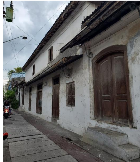
Gambar 9. Atap Kanopi dan Molding (sumber : Dokumen Penulis, 2024)
