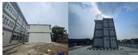
Gambar 5. Ruang Terbuka Proyek BLK (sumber: Dokumentasi Penulis, 2023)
