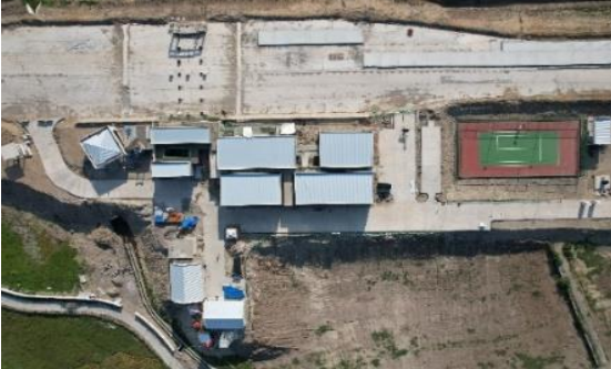
Gambar 1. Kondisi Existing Lahan (sumber: Dokumentasi Mingguan PT. Adhi Karya Tbk., 2023)
