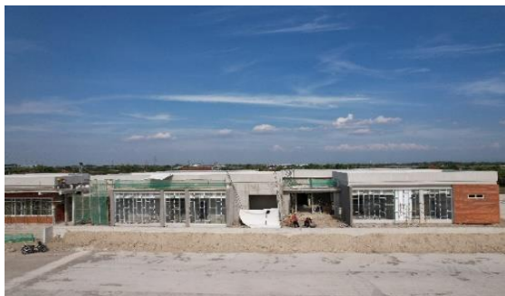
Gambar 4. Jendela Kaca Ruang Kerja JMTM (sumber: Dokumentasi Mingguan PT. Adhi Karya Tbk., 2023)
