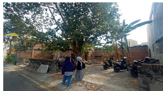
Gambar 2. Laboratorium Nila masih dalam Pembangunan
