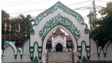
Gambar 2. Pintu Utama Masjid Al Wustho Mangkunegaran (sumber: tribunsolowiki.com, 2020)
