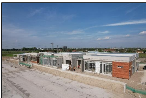
Gambar 3. Jendela Kaca Bangunan Kantor Operasional dan Kantor Pos Tol
