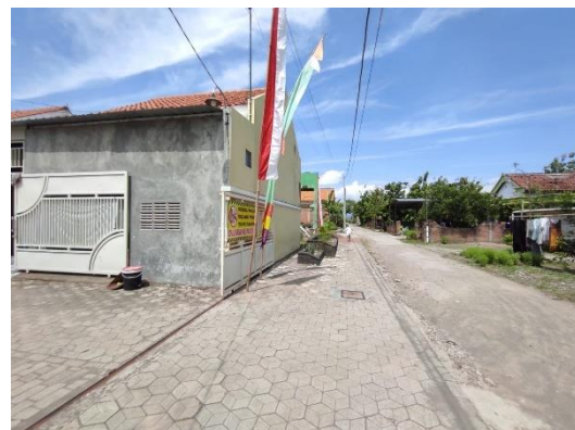
Gambar 21. Jalan Perumahan Bangun Rejo Indah (Sumber: Dokumen Penulis, 2023)
