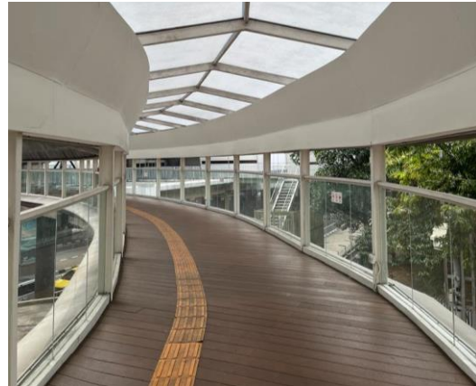
Gambar 2. Jembatan penghubung antar-peron halte (Sumber: Dokumen Penulis, 2023)
