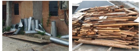
Gambar 1. Limbah Konstruksi Sisa Pembangunan (Sumber: Dokumen Penulis, 2023)
