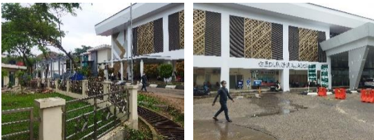
Gambar 11. Kondisi Batas Lahan Bangunan (Sumber: Dokumen Arsitek, 2023)
