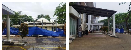
Gambar 7. Lokasi Pembangunan Ruang Tunggu UGD (Sumber: Dokumen Penulis, 2023)
