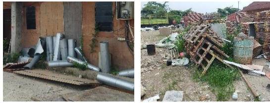
Gambar 12. Limbah Konstruksi Sisa Pembangunan (Sumber: Dokumen Penulis, 2023)
