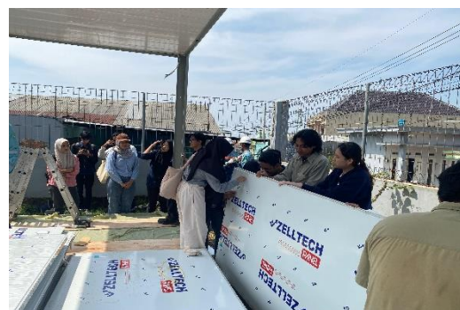
Gambar 11. Pengalaman Praksis Instalasi konstruksi WG Flatpack di lapangan
