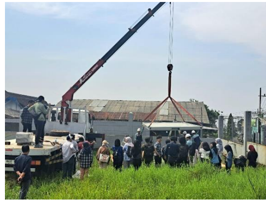
Gambar 10. Pemahaman Teknis metoda Instalasi konstruksi WG Flatpack di lapangan
