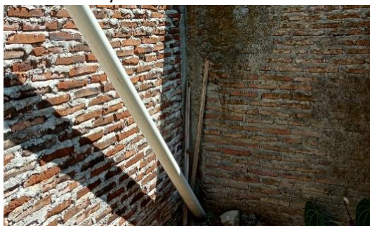
Gambar 4. Foto eksisting rumah subsidi (sumber : hasil survei, 2024)
