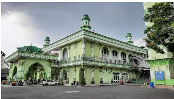
Gambar 1. Kondisi bangunan Masjid Raya Klaten (sumber: Dokumentasi penulis, 2024)
