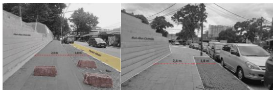
Gambar 4. Pedestrian dan Parkir Bahu Jalan
