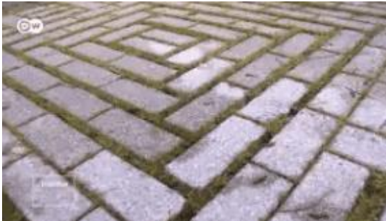
Gambar 5 Penggunaan Beton Daur Ulang sebagai Paving Blok (Sumber: dw.com/indonesian, 2024)
