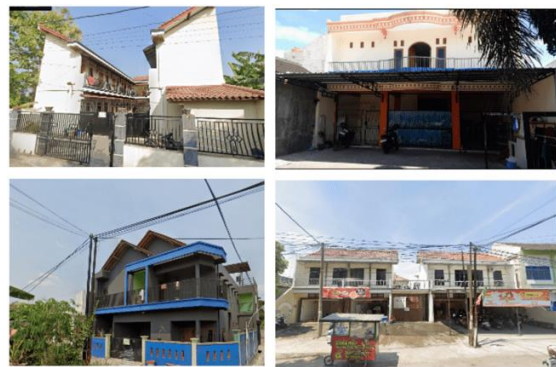
Gambar 1. Kondisi Eksisting Beberapa Bangunan Asrama (Sumber: Dokumentasi Penulis, 2024)
