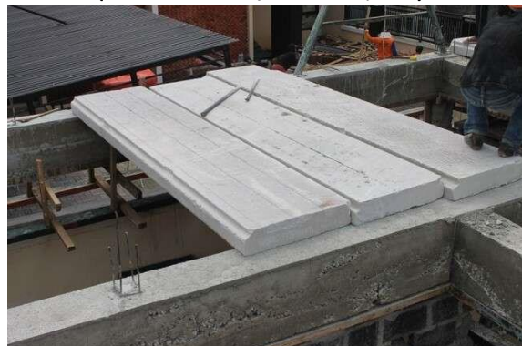
Gambar 4 Beton Konvensional sebagai Panel Lantai (Sumber: megatrussjualpanellantai.blogspot.com ,2024)
