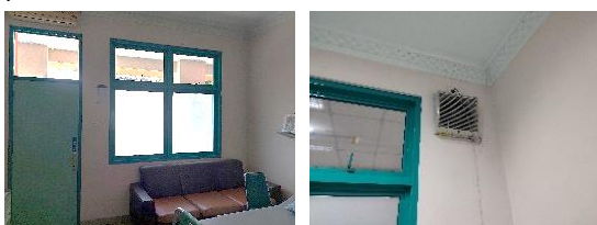
Gambar 12. Jendela Kamar Inap Kelas 1 Dan Kelas 3 (sumber: Penulis, 2024)
