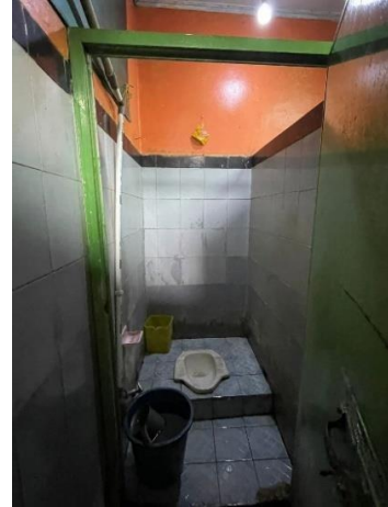
Gambar 12. Kondisi Dalam Toilet (Sumber : Dokumen Penulis, 2024)
