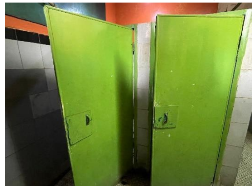
Gambar 13. Kondisi luar toilet (Sumber : Dokumen Penulis, 2024)
