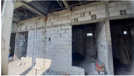
Gambar 6. Buka-an fasad bangunan (Sumber: Dokumentasi Penulis, 2024)
