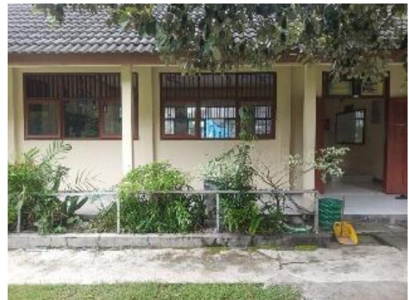
Gambar 11. Kondisi Eksisting Bukaan (sumber: Hasyim,2024)
