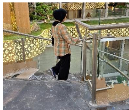
Gambar 12. Diameter Handrail Tangga Melingkar The Gade Tower, Jakarta Pusat (Sumber: Dokumen Penulis, 2024)
