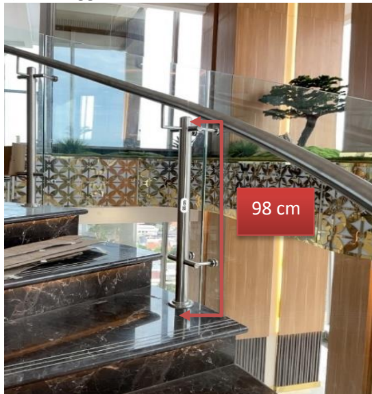
Gambar 10. Tinggi Handrail Tangga Melingkar The Gade Tower, Jakarta Pusat (Sumber: Dokumen Penulis, 2024)
