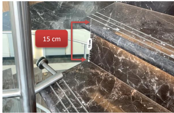
Gambar 6. Tinggi Anak Tangga Melingkar The Gade Tower, Jakarta Pusat (Sumber: Dokumen Penulis, 2024)
