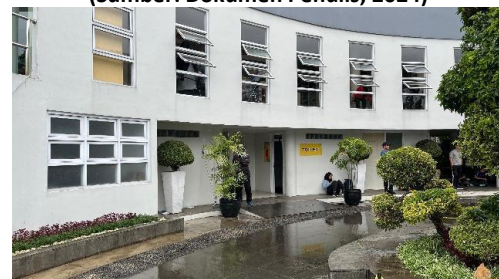
Gambar 18. Toilet Umum Lapangan Gasibu (Sumber: Dokumen Penulis, 2024)
