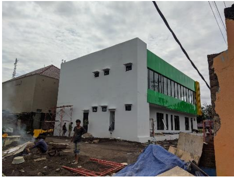
Gambar 5. Tampak belakang gedung baznas Karanganyar (sumber: Dokumentasi Penulis, 2024)
