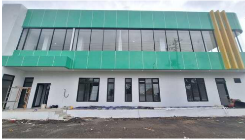
Gambar 15. Jendela dan Pintu Gedung BAZNAS (Sumber: Dokumentasi Penulis, 2024)
