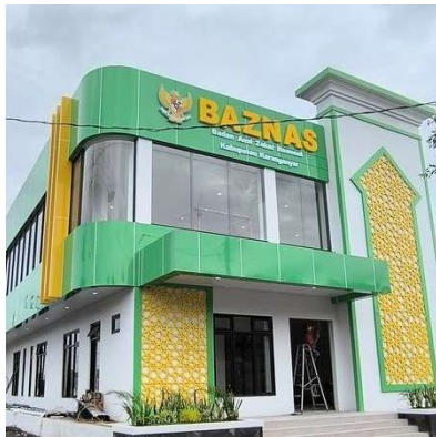
Gambar 11. Fasad Sebelah Selatan (Sumber: Dokumentasi Penulis, 2024)
