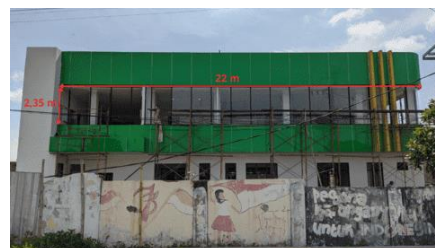
Gambar 10. Fasad Sebelah Barat (Sumber: Dokumentasi Penulis, 2024)
