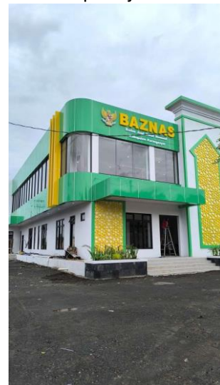
Gambar 4. Perspektif Gedung BAZNAS (Sumber: Dokumentasi Penulis, 2024)
