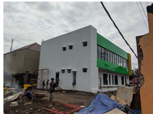
Gambar 5. Perspektif Gedung BAZNAS (Sumber: Dokumentasi Penulis, 2024)
