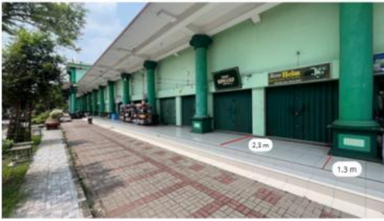
Gambar 14. Deretan Kios Stadion Trikoyo (Sumber: Dokumen penulis, 2024)
