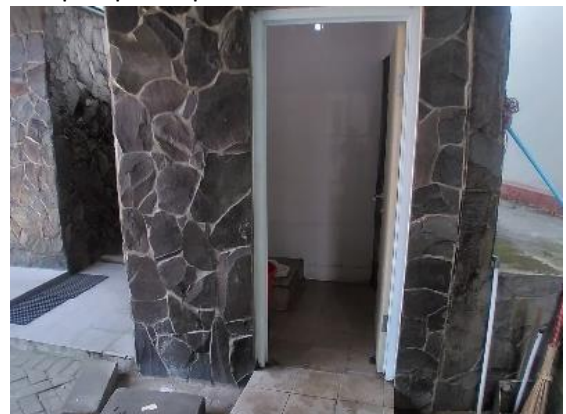
Gambar 9. Kondisi toilet (sumber: Dokumen Penulis, 2024)
