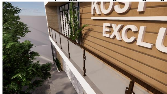
Gambar 17. Penggunaan material transparan pada bagian railing balkon (sumber: Dokumentasi Penulis, 2024)
