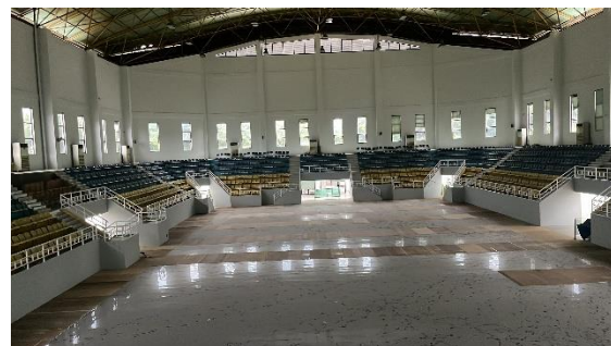
Gambar 22. Lantai Epoxy Pada Arena
