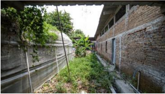
Gambar 7. Tidak Adanya Akses Menuju Ruang Hijau (sumber: Dokumentasi Penulis, 2024)
