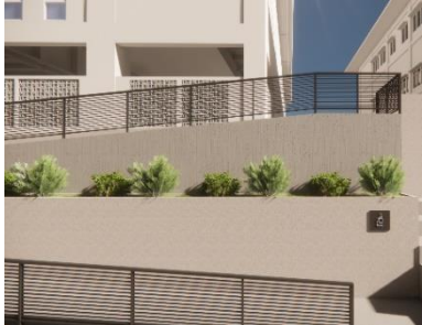
Gambar 15. Terdapat hand railing pada ramp. (Sumber: Desain Penulis, 2024).
