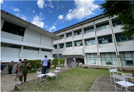
Gambar 5. Kondisi Bangunan Sebelum Menjadi JNM Bloc (sumber: archinesia.com) Diakses pada 7 November 2024
