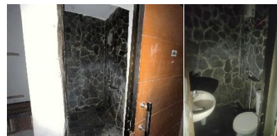
Gambar 10. Area toilet (Sumber: Dokumen Penulis, 2024)
