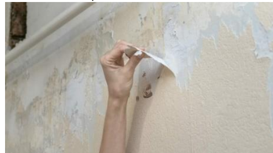
Gambar 4. Cat Mengalami Pengelupasan (Sumber: Google Image/cat)
