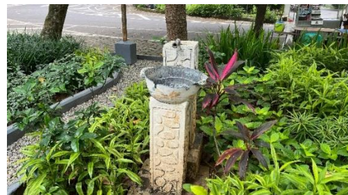
Gambar 10. Wastafel yang rusak (Sumber: Dokumentasi pribadi, 2024)
