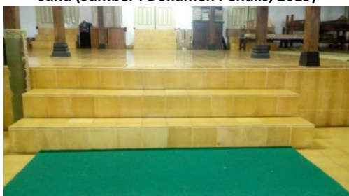
Gambar 6. Lantai berundak yang mampu menurunkan suhu (Sumber : Dokumen Penulis, 2019)
