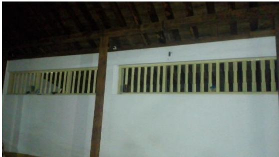
Gambar 3. Kisi-kisi angin-angin yang ada di dinding sisi utara-selatan masjid (Sumber : Dokumen Penulis, 2019)
