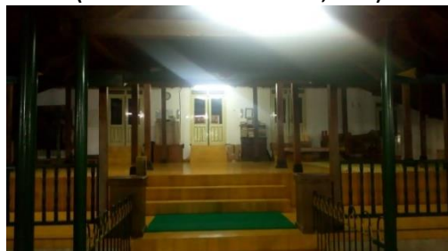
Gambar 5. Lantai berundak yang mampu menurunkan suhu (Sumber : Dokumen Penulis, 2019)
