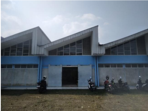
Gambar 1. Tampak depan ruang praktik teknik konstruksi dan perumahan Sumber: Wibawa (2025)
