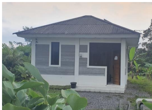
Gambar 1. Rumah percontohan T. 36 dengan 3D printing di Turi, Sleman, Yogyakarta (sumber: Yuke Ardhiati, 2025).
