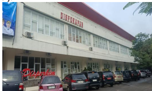
Gambar 2. Kantor Dinas Perumahan dan Kawasan Permukiman Kabupaten Boyolali
