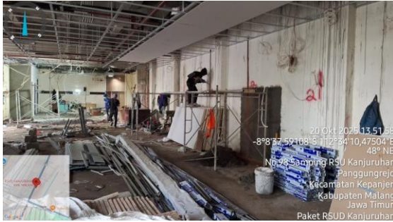
Gambar 3. Proses Pembangunan IGD RSUD Kanjuruhan. (Sumber: Dokumen Penulis, 2025)
