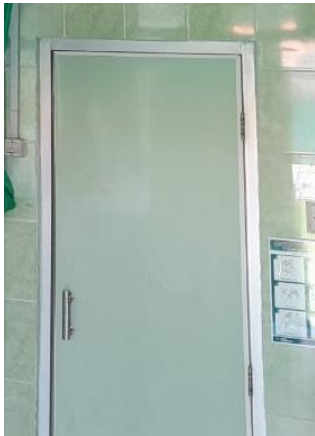
Gambar 9. Pintu Kamar Mandi di Ruang Rawat Inap (Sumber: Dokumen Penulis, 2025)
