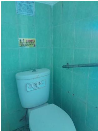
Gambar 8. Handrail pada Ruang Rawat Inap Kelas III (Sumber: Dokumen Penulis, 2025)
