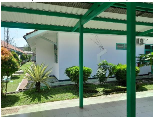
Gambar 5. View Koridor Ruang Rawat Inap Kelas III (Sumber: Dokumen Penulis, 2025)
