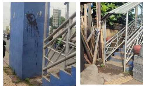
Gambar 3. Kondisi Akses Depan Tangga JPO Bundaran Alam Sutera
