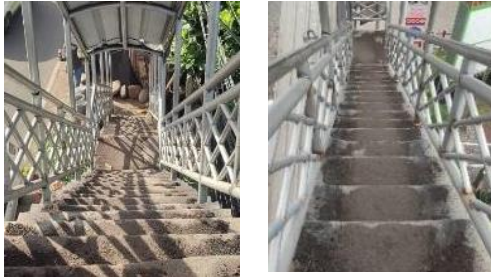
Gambar 5. Kondisi Lebar Tangga JPO Bundaran Alam Sutera (sumber: Dokumentasi Penulis, 2025)
