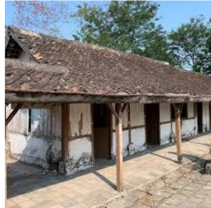
Gambar 10. Kondisi Atap Bangunan (Sumber: Dokumentasi Penulis, 2025)
