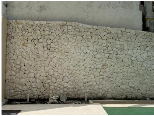
Gambar 1. Dinding dari Batu alam (sumber: Dokumentasi penulis, 2025)
