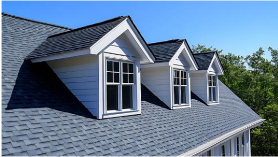
Gambar 3. Atap Mansard dan penambahan Dormer (Sumber : Guertin, 2024)
