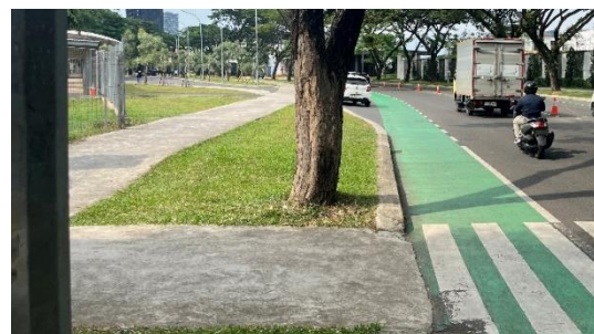
Gambar 4. Kondisi Kemiringan Ramp Pedestrian (Sumber : Dokumen Penulis, 2025)
