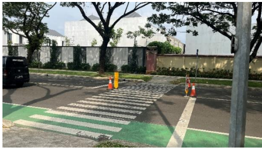
Gambar 6. Kondisi Fasilitas Penyebrangan (Sumber : Dokumen Penulis, 2025)
