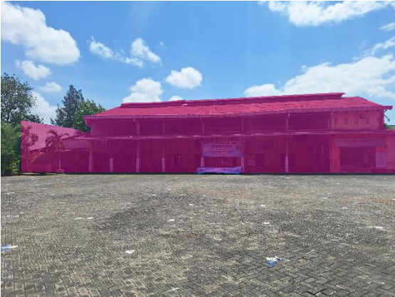
Gambar 11. Foto Menunjukkan Elemen Baru yang Merupakan Tambahan Bukan Elemen atau Struktur Asli (Sumber: PT. Hermawan Dasmanto Architect, 2025)
