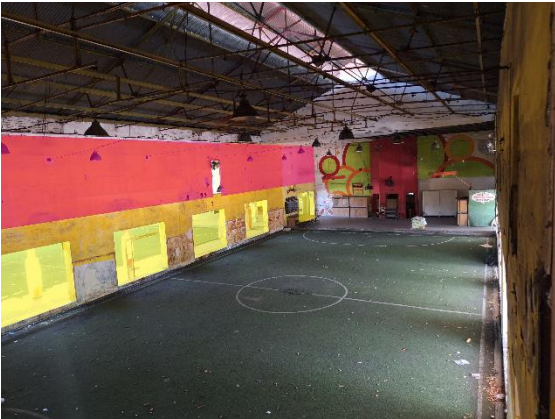
Gambar 12. Foto Menunjukkan Elemen Tambahan dan Pengurangan yang terjadi pada Struktur dan Elemen Asli
