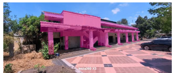
Gambar 10. Foto Menunjukkan Elemen Baru yang Merupakan Tambahan Bukan Elemen atau Struktur Asli
