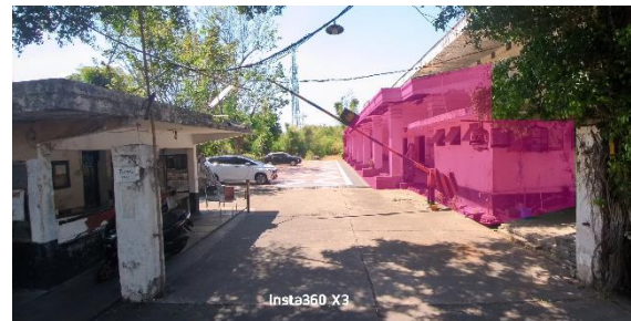
Gambar 9. Foto Menunjukkan Elemen Baru yang Merupakan Tambahan Bukan Elemen atau Struktur Asli
