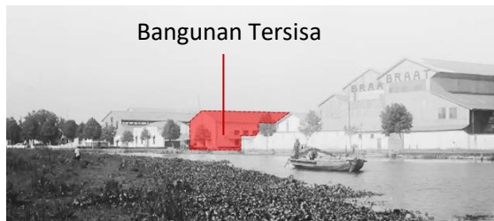
Gambar 5. Foto menunjukkan sisi barat kawasan pabrik N.V Braat diambil dari sebrang kalimas (Sumber: SurabayaStory.com, 2025)
